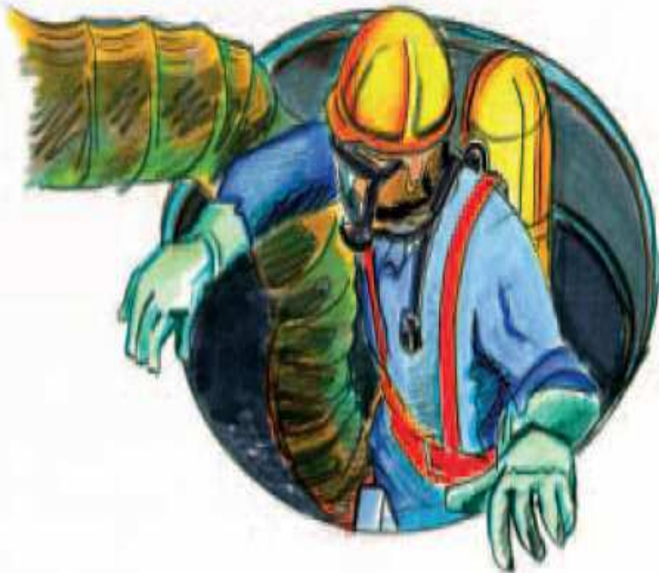
Figura 8: All'interno di pozzi, fosse e canalizzazioni che non possono essere ventilati sufficientemente, occorre in ogni caso indossare un respiratore indipendente dall'aria circostante.
