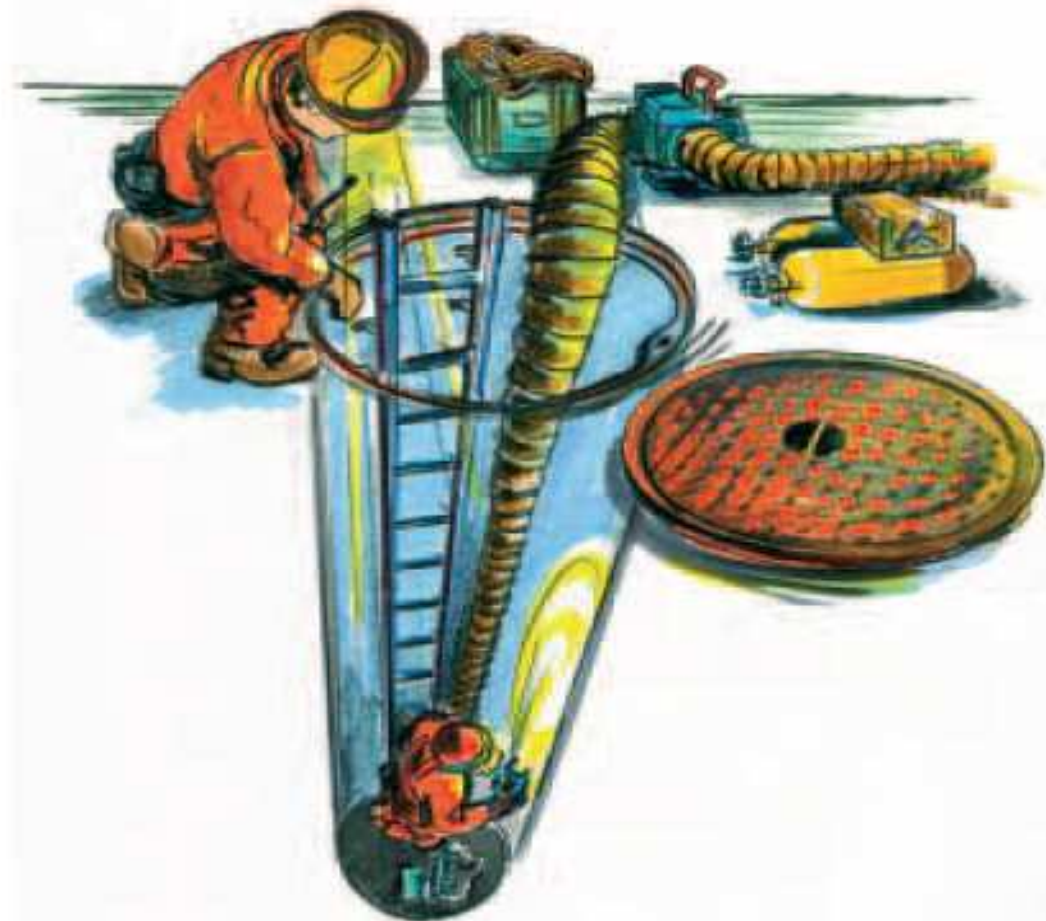
Figura 9: Le persone entrate in pozzi, fosse e canalizzazioni sono sorvegliate dall'esterno. Al verificarsi di situazioni d'emergenza o nel caso di un incidente l'addetto alla sorveglianza dà immediatamente l'avvio alle operazioni di salvataggio.
